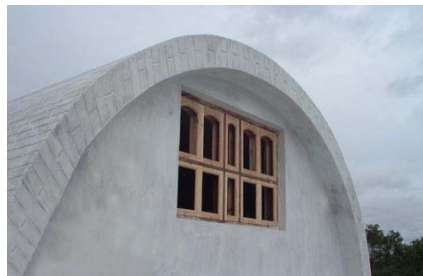
2階屋根裏部屋の窓
